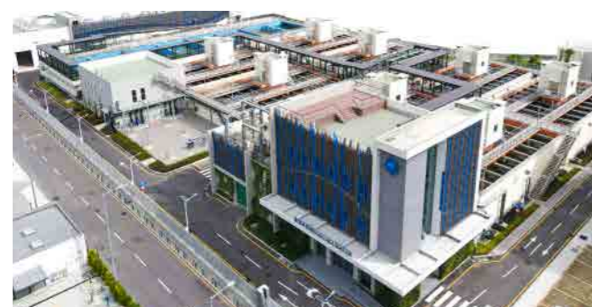
興建水廠、水庫、水池等供水設施
