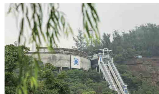
氹仔50米高位水池
