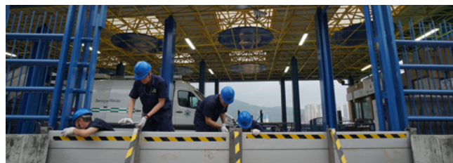
安裝防水旱閘擋水板 A montar painéis de retenção de água
