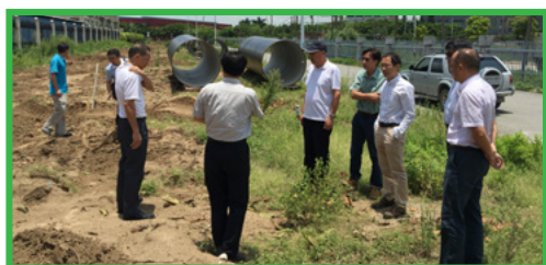
本局人員聆聽施工單位代表講解鋼管施工步驟
