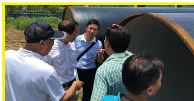
本局人員視察施工現場放置的鋼管
