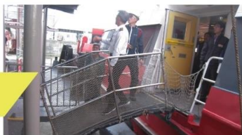
檢查躉船登乘設施 Vistoria às instalações de embarque/desembarque do batelão
