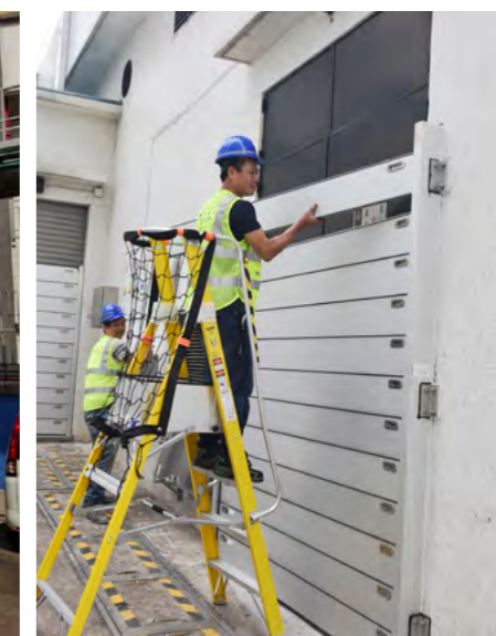
水廠安裝最高級別防水閘 Foi instalado o painel de retenção de água da categoria máxima na Estação de tratamento de água
