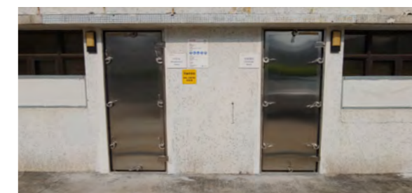
安裝及緊閉水密門 A porta de estanque foi instalada e fechada
