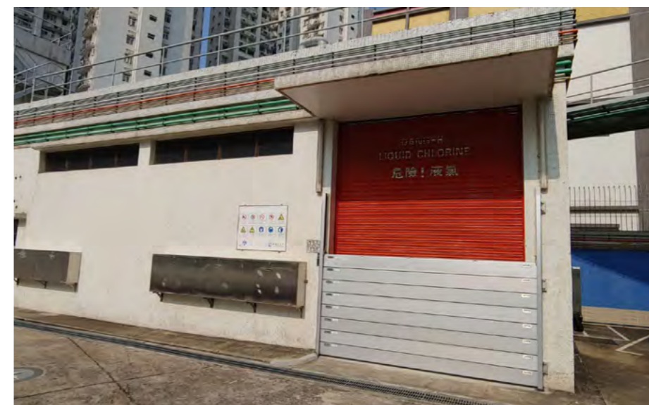
水廠安裝最高級別防水閘 Foi instalado o painel de retenção de água da categoria máxima na Estação de tratamento de água
