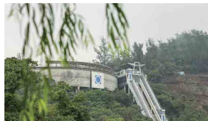
氹仔50米高位水池
