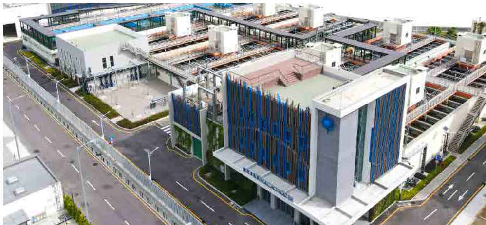
興建水廠、水庫、水池等供水設施
