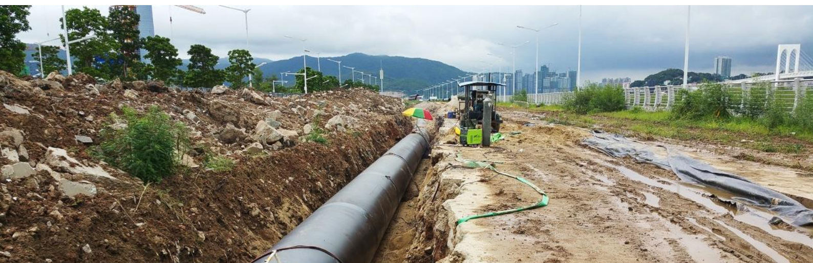
圖11 第四條對澳供水管道施工情況
