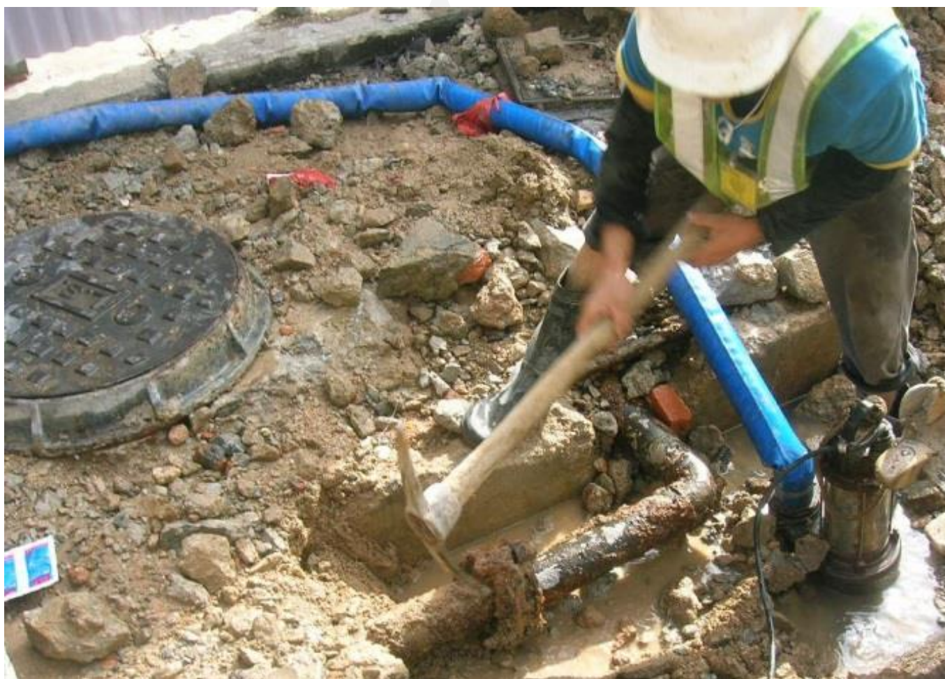
圖17 逐步更換老化水管以改善管網漏損情況
