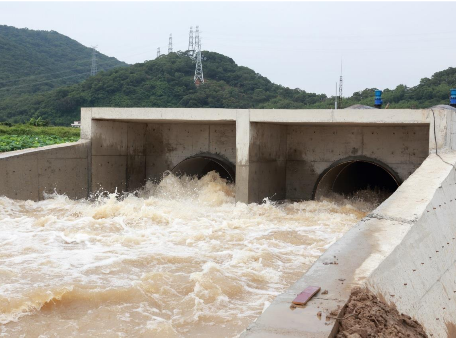
圖12 對澳供水洪灣西引水渠改造工程現況
